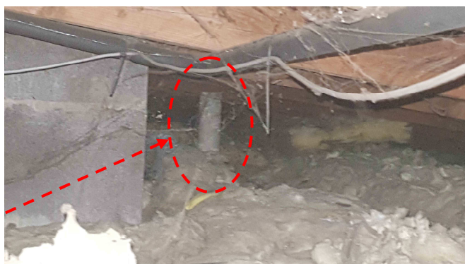
Grille n° 3 – Conduit de ventilation dans combles
