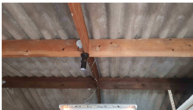
Grille n°2 – Couverture fibrociment sur garages et autres annexes
