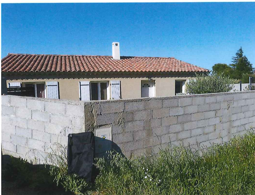
N°6-FACADE NORD DE LA MAISON ET MUR DE CLOTURE, VUS DEPUIS LA VOIE PUBLIQUE
