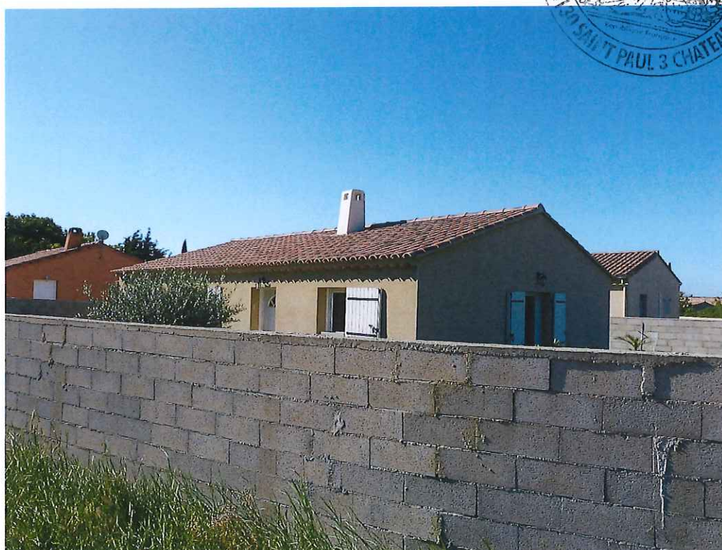
N°5-FACADES NORD ET OUEST DE LA MAISON ET MUR DE CLOTURE, VUS DEPUIS LA VOIE PUBLIQUE-
