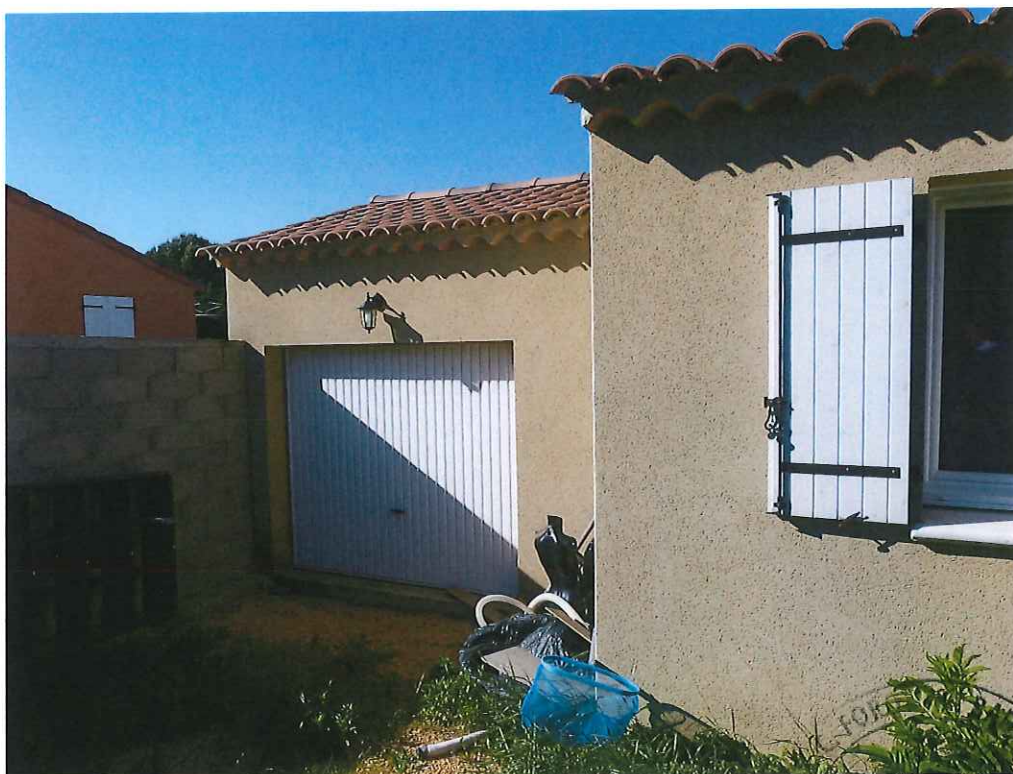
N°2-FACADE NORD DU GARAGE CONTIGU-
