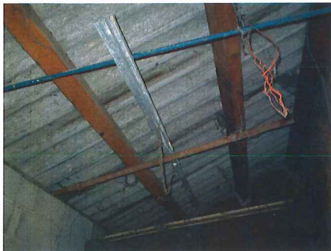
Ondes fibrociment sur Garage
