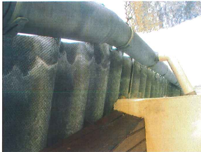
Ondes en fibrociment sur Maison
