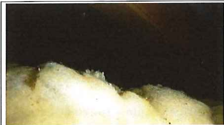
Photo Combles Localisation : 1er étage - Chambre 2
