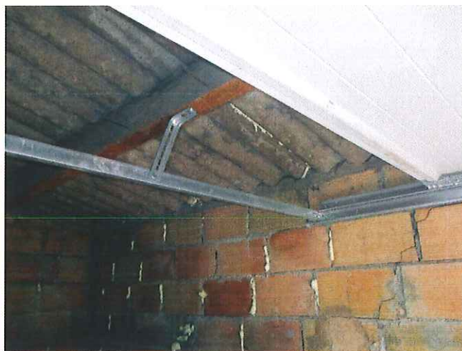
Ondes fibrociment sur Garage
